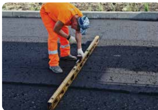
3-х метрова рейка для контролю рівності та похилів
